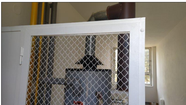
foto č. 7: Plynový zásobníkový ohřev vody na chodbě QUADRIGA QT 75
