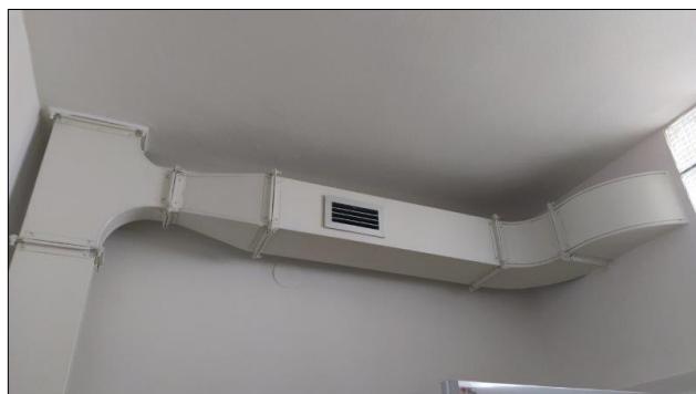
foto č. 16: Odtahové potrubí VZT v hygienickém zázemí
