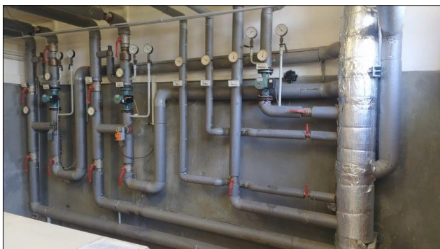
foto č. 9: Hlavní rozvodna topné vody
