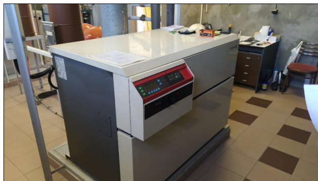
foto č. 8: Plynový kotel 2 x DE Dietrich DTG360-13 o výkonu 2 x 154 kW v kotelně objektu
