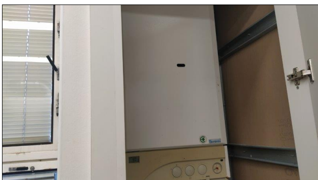
foto č. 11: Plynový kotel ITherm 14 TXZ ve cvičné kuchyni
