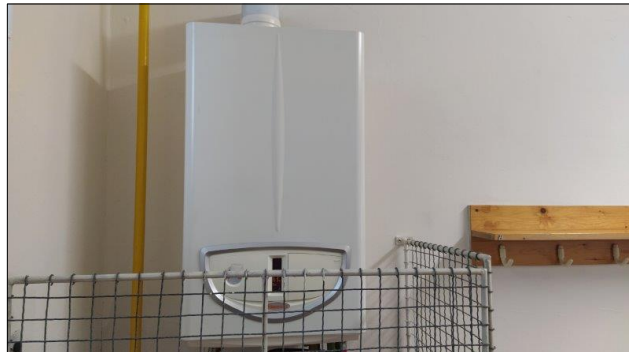
foto č. 6: Plynový kotel v šatně tělocvičen IMMERGAS MAIOR EOLO 24 kW
