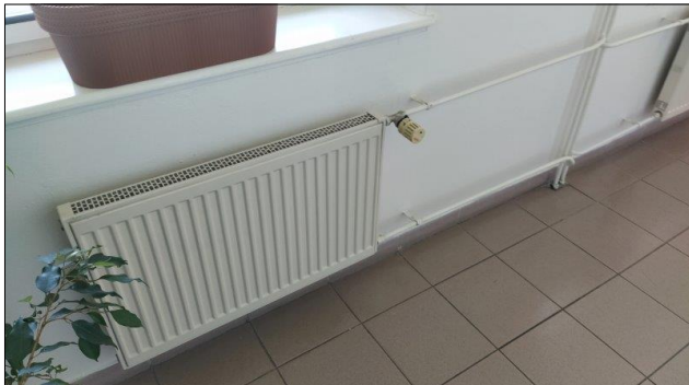
foto č. 5: Vytápění objektu deskovými radiátory s termoregulační hlavicí
